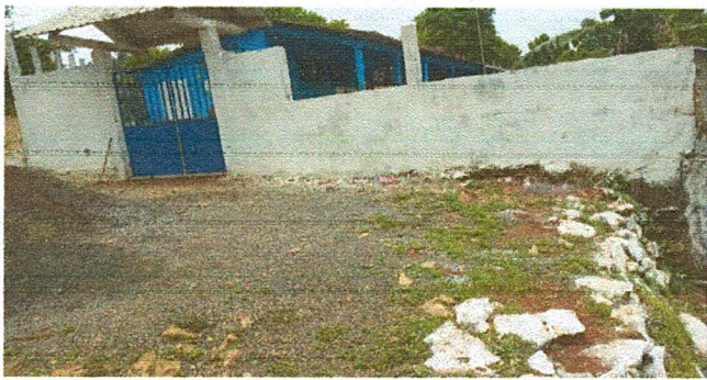
Foto 3: Mantenimiento del portón
