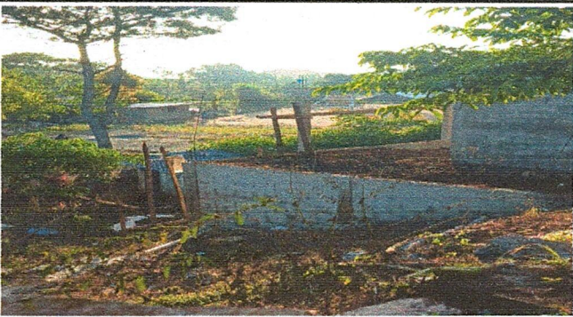
Foto 5: Levantado de muro
