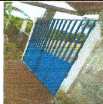
Foto 6: Mantenimiento del portón
