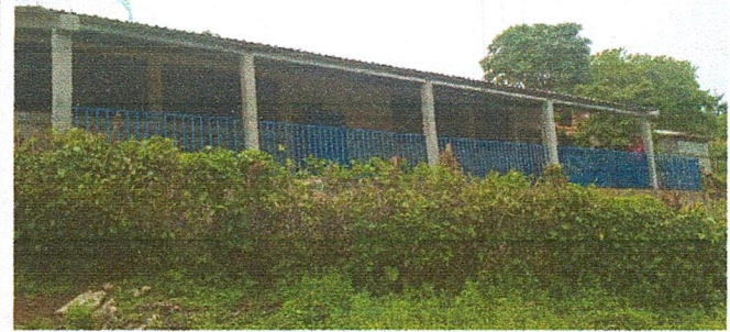
Foto 4: Mantenimiento de puertas y ventanas
